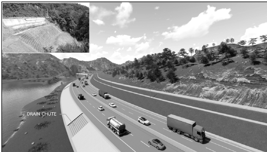
รูปที่ 6.3-5 รูปแบบก่อสร้างระบบระบายน้ำแบบขั้นบันได
